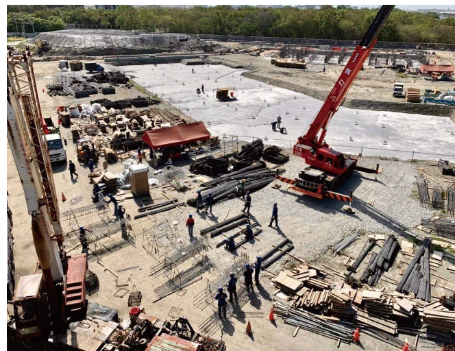
會員度假中心-基礎鋼筋綁紮
