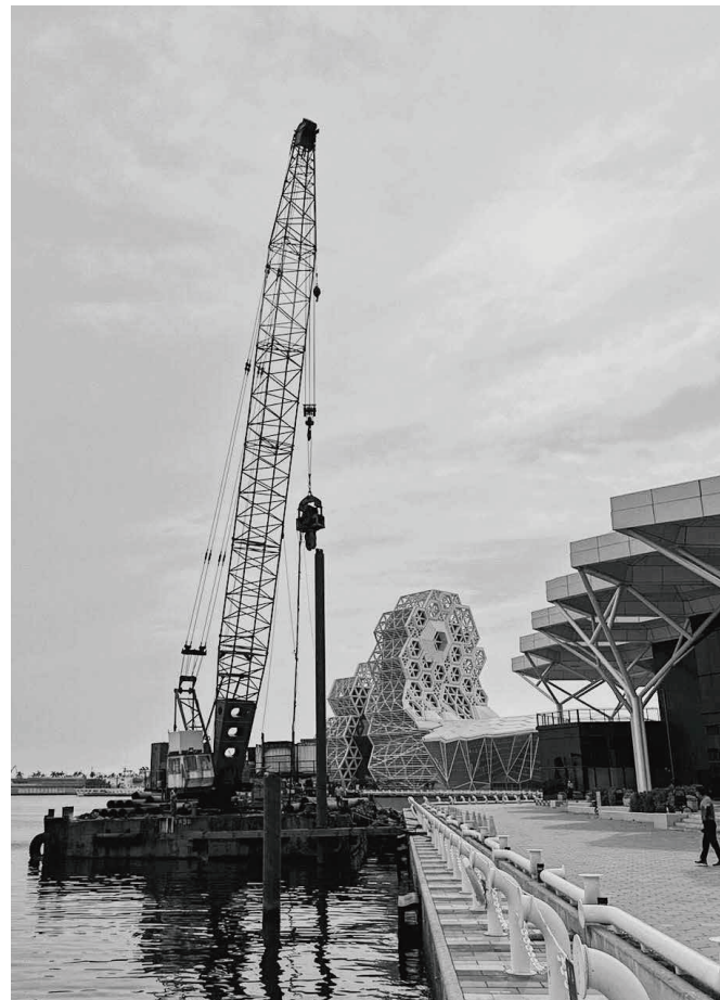
愛河灣-管樁打設工程
